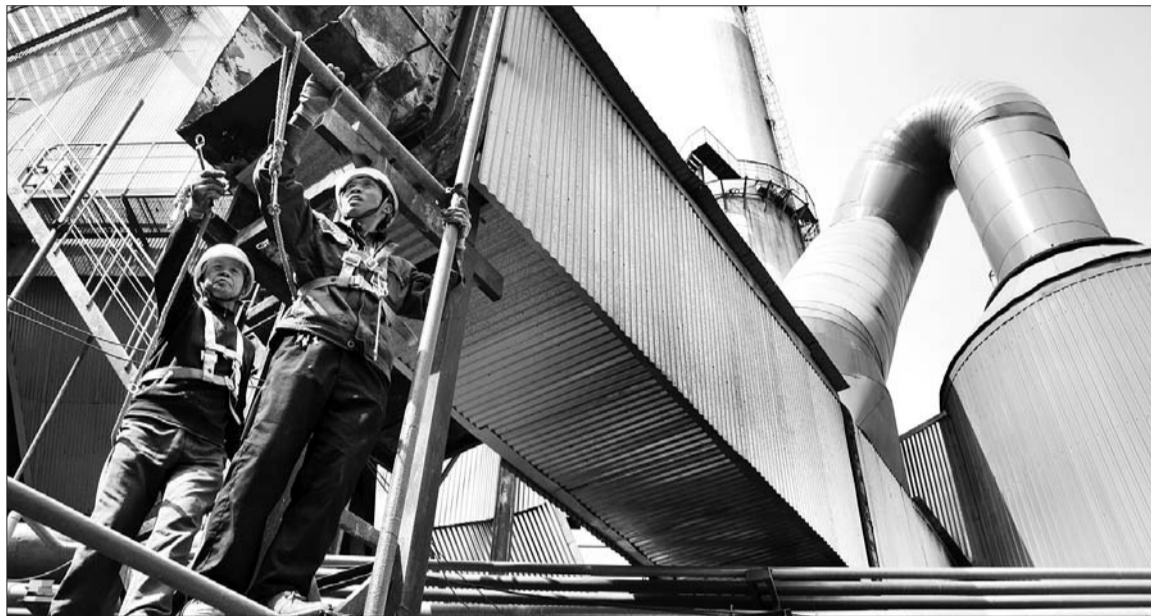
东郊热电升级烟气排放设施,施工工人正在拆除脱硫塔的相关设施。本报记者张晓明摄(资料图)
