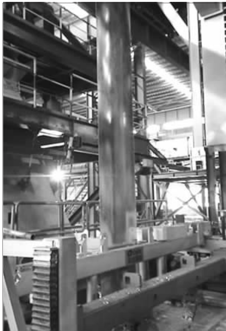
江苏罗德科技有限公司25万吨连续热镀锌铝锌机组日前实现一次性热负荷试车,并直接生产出合格品。
