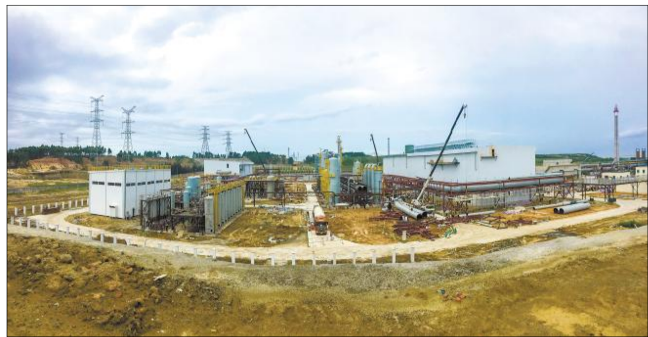
近日,湛江钢铁循环经济项目完成三维设计并开始全面施工。该项目是宝钢工程工程技术事业部本部动力事业部A级设计项目(E),包括焦炉煤气制氢气和液化天然气站、制氮站新增液氧备份系统以及送钢厂和中科煤化的动力管网三部分。 记者 施 琼 通讯员 应 明 摄影报道
