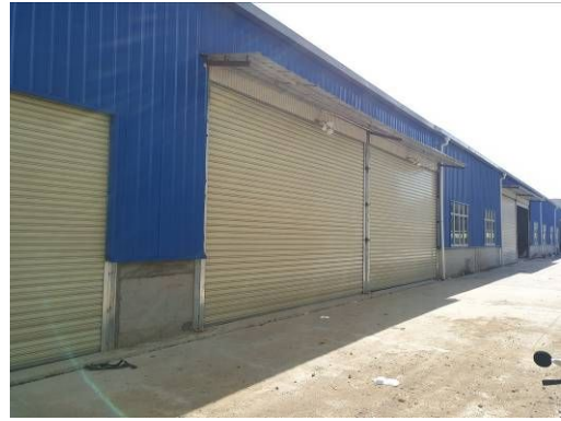
项目东北侧为他人工艺品厂
