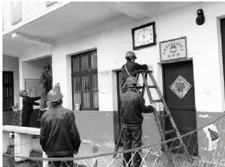
长沙电业局“雷锋共产党员服务队”为敬老院修整线路。
