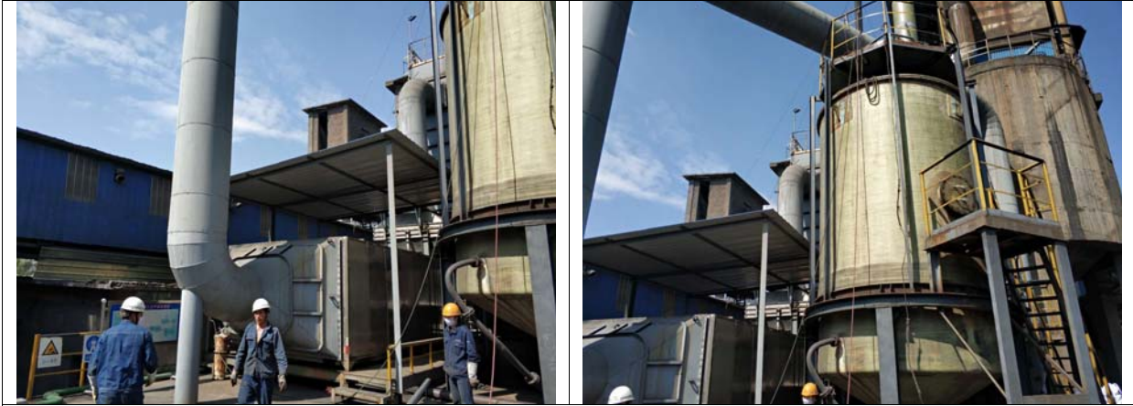
粗粒干燥废气治理措施（布袋除尘+UV光解活性炭一体机+干雾水浴除尘）
