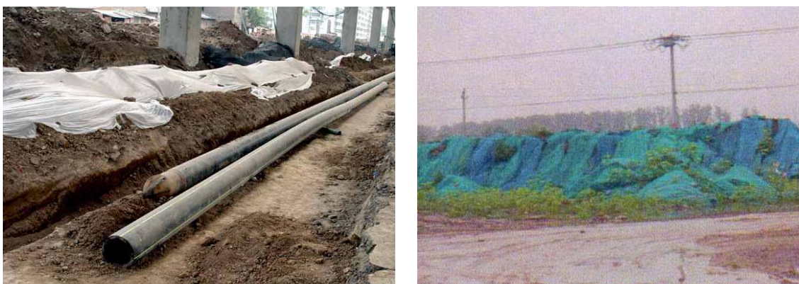
图 4-4 纱网遮盖管道临时堆土覆盖
