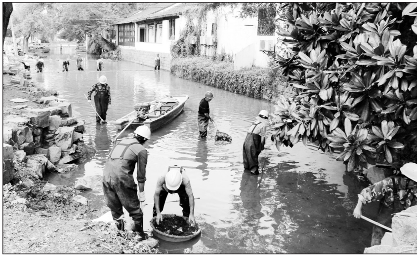
江苏省苏州市古典园林沧浪亭河塘清淤工程近日启动。此次清淤主要靠清淤排污泵和人工作业,清淤后的沧浪亭将以更优雅洁净的环境迎接中外游客。 中国日报图片网供图
