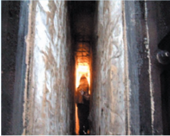
宝钢焦炉进行热态修理时的场景
