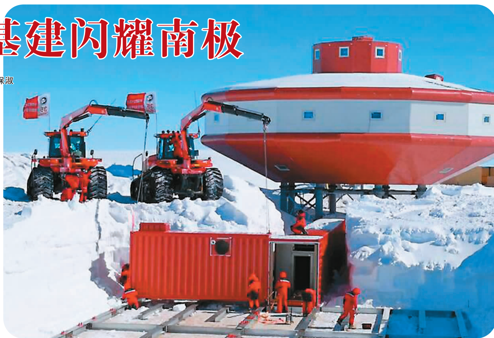
泰山站雪下工程建设现场
