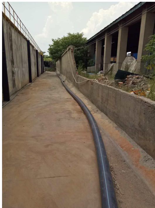
废水输送管道
