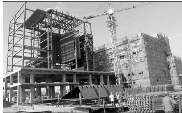
跑项目节省了时间,公司商河的厂房也很快投入建设。
