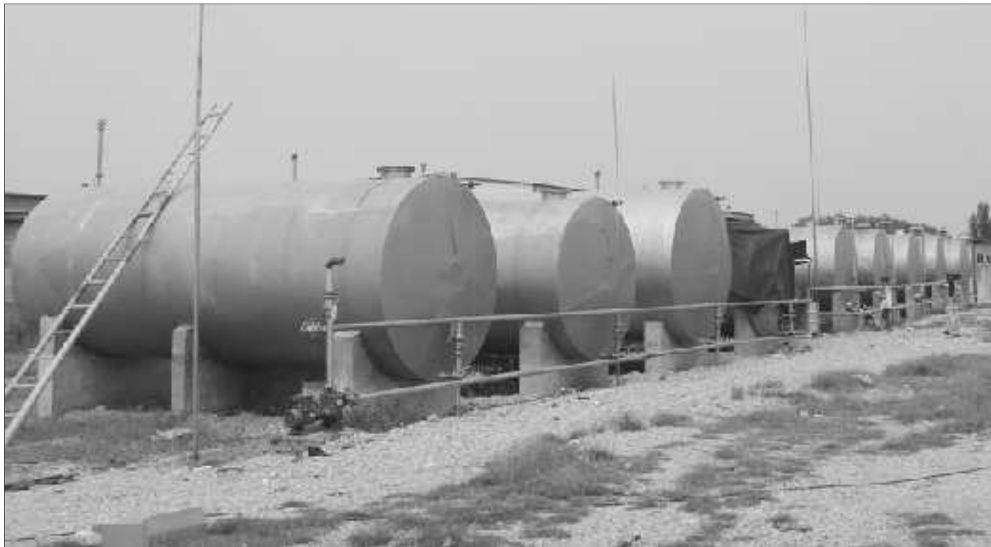
9个大罐一字排开放置在空地上,据称该厂区正在等待建设。
