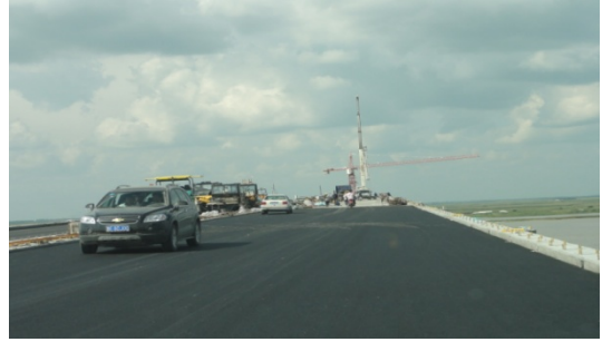
富绥跨江大桥
