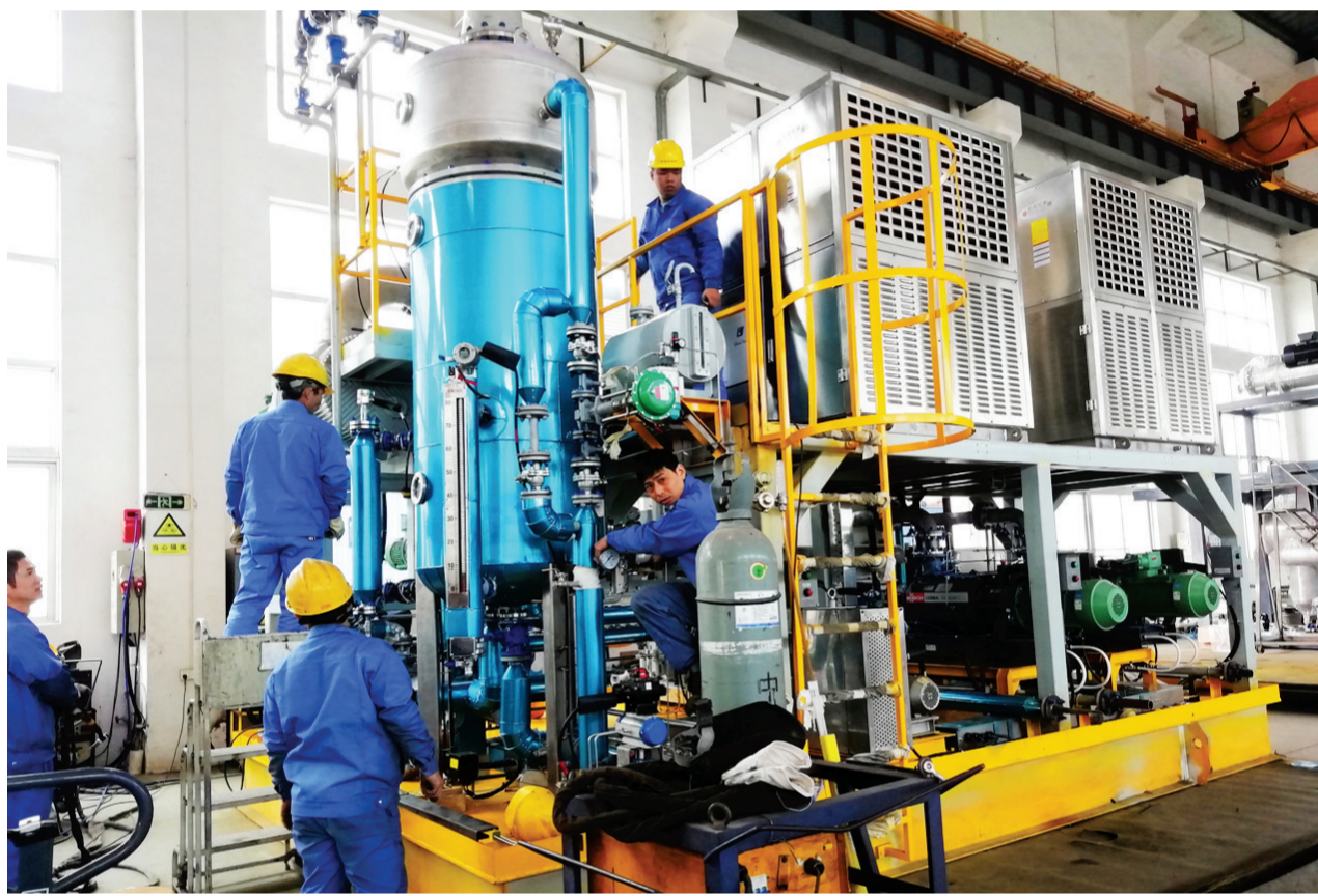
技术人员在组装原油闪蒸设备。
