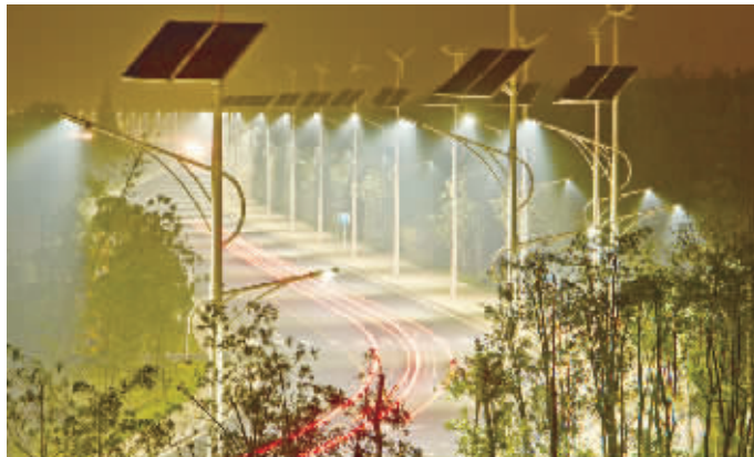
长沙市望城区星城镇,湘江景观道路两旁矗立着一排排风光互补路灯,利用太阳能和风能发电,自然、清洁。 记者 张京明 摄
