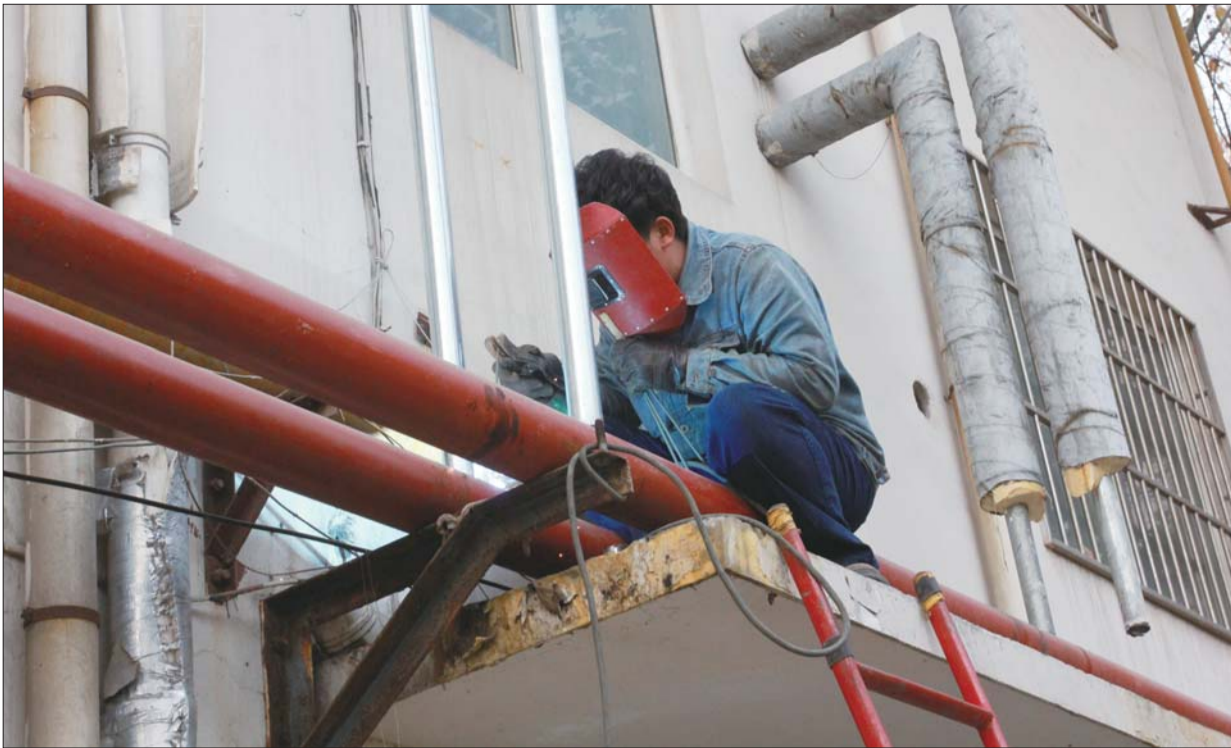
工作人员正在焊接供暖管道。 实习生 李洋 摄
