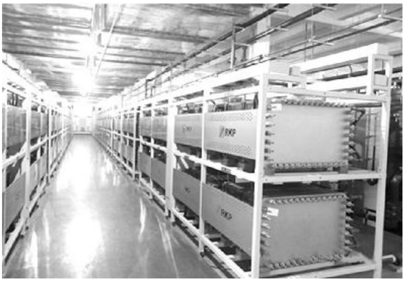
全钒液流电池储能技术具有使用寿命长、规模大、安全可靠等突出优势。
