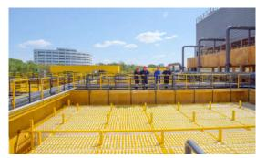
公司重点环保工程——污水提标改造项目,在公司相关部门和施工方的共同努力下,已经相继完成调节池、水解酸化池、凉水塔、接触氧化池等主体工程建设、设备安装工作。5月20日,调节池、水解酸化池开始注水试运。21日凉水塔开始试运行,为高温季节污水系统的稳定运行提供有力保障。
