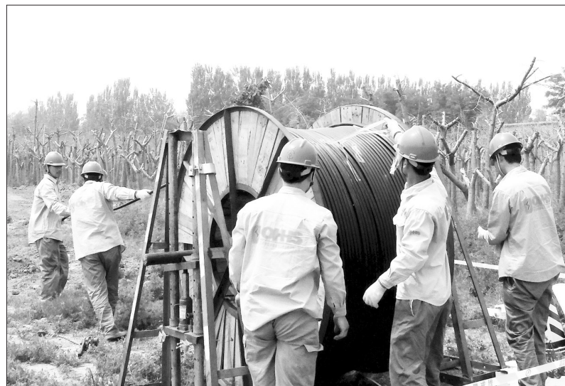
北京市丰台区委、区政府制定了《丰台区2016~2017年煤改气工程实施方案》,压减燃煤,优化能源结构。全区今年将完成煤改清洁能源3.41万户,到2017年底,全区基本实现无煤化。图为供电部门正在新建、改建、扩建8座变电站,确保明年全区万余户煤改气工程项目的顺利实施。 本报记者邓佳摄
