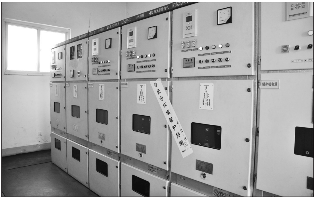
广汇化工有限公司利用暗管、渗坑偷排化工废液环境违法行为被查处后,寿光市环保局对其供电设备、生产设备予以查封。图为供电设备上贴着的封条。季英德 董若义摄
