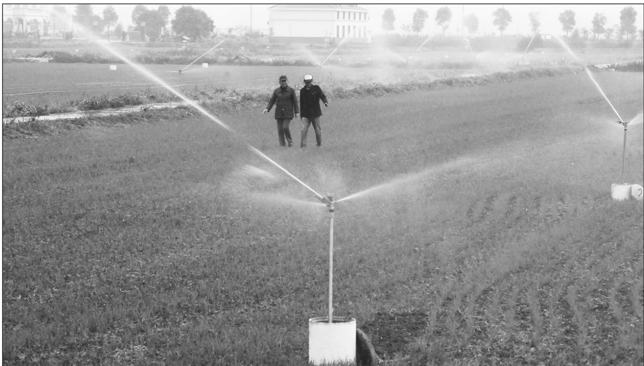
明光市潘村湖农场作为安徽省农垦集团节水灌溉高产示范区项目实施单位,安装了固定式和卷盘式多种节水喷灌设备。这些设备节能、节水并节省劳动力,又提高了农田产量,受到当地农民青睐。据悉,使用自动喷灌节水系统后,规模在600亩地一季冬小麦的浇灌成本可节约3万元。人民图片网供图
